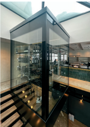
Der Weinturm wurde in der Halle vorproduziert und an Ort und Stelle von Maximilian Reiter mit seinem Team zusammengebaut und aufgestellt.
