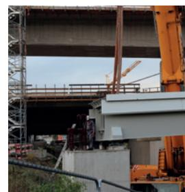
1. Foto links: Der sogenannte 1.000 Tonnenkran wurde für die großen Stahlbauteile verwendet. Weitere Fotos: Zwei Schwerlastkräne haben die beiden großen Elemente für den Radweg eingehoben.
