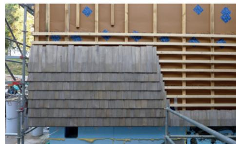
Die Fassadenbekleidung aus Fichteschindeln an den Gebäudeteilen E und F wurde an einer Holz-Unterkonstruktion befestigt, die Fischer SXR Langschaftdübel in Beton verankern. Foto: Vermögen und Bau Baden-Württemberg Amt Pforzheim
