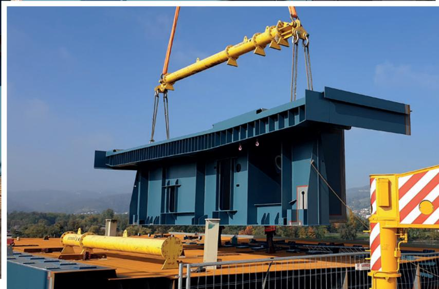
Wasser sondern über Land. So wurden die langen aber schmalen Stahlbauteile mit den bereits bekannten selbstfahrenden Schwerlastanhängern vom Vormontageplatz über den Donauradweg, unter der Brücke durch, zu den angestammten Positionen befördert. Die baustellenbedingten engen Umgebungsbedingungen machten den Transport der sperrigen Bauteile zur schweißtreibenden Millimeterarbeit, die auch in diesem Fall perfekt gelang. Mit zwei großen Schwerlastkrä-
