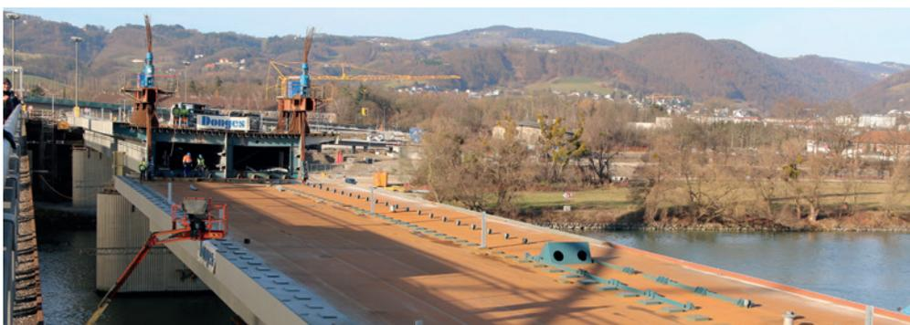
Über die auf den Seitenteilen montierte Hubvorrichtung wurde das Mittelstück an seine Position gehoben.
