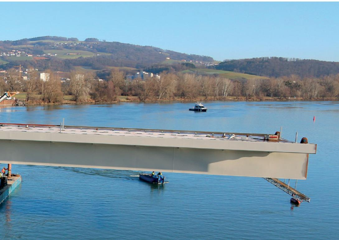
Lücke herangeführt. Dabei spielte das „Einfädeln“ des Stahlkolosses eine zentrale Rolle. Die Schwerlastkähne wurden über Stunden mit Stahlseilen langsam in die angestammte Lücke gezogen, bis die exakte Position am Wasser erreicht war.
