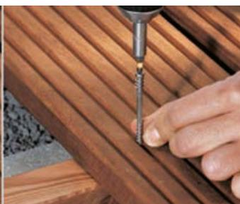
SPAX®-D gerade ansetzen. Ohne unterbrechung kopfbündig verschrauben.
