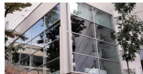
Die Glasfassade im ORF-Erlebnisturm besteht unter anderem aus 700 kg Glas.
