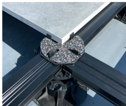
Verlegung auf einer Aluminium- Unterkonstruktion
