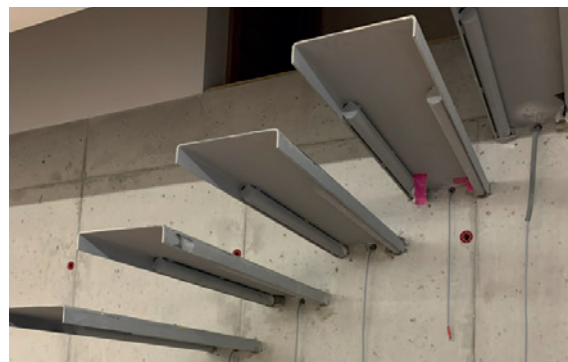
Die Kragarmstiegen mit Beleuchtung bedürfen einer exakten Planung, in einer Betonwand ist kein Geländer erforderlich.
