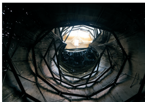
Die Innenansicht von "Unitatis" offenbart einen schönen Einblick in die Grundkonstruktion.
